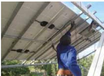
pour satisfaire la demande d'énergie que ce type d'équipement nécessite. Composé par des panneaux solaires, un contrôleur de charge et des batteries, ce système fournit de l'énergie continue qui est nécessaire pour maintenir un fonctionnement sans faille.
