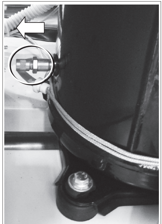
Den Schaltkasten verschieben um Zugang zur Ölstandanzeige zu erhalten.
